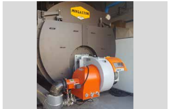
FÁBRICAS DE PAPEL - PROYECTO ESPECIAL Modelo de quemador: TBG 1100 ME V O 2 FGR - Control de O 2 , inverter y recirculación de humos NOx <80 mg/kWh
