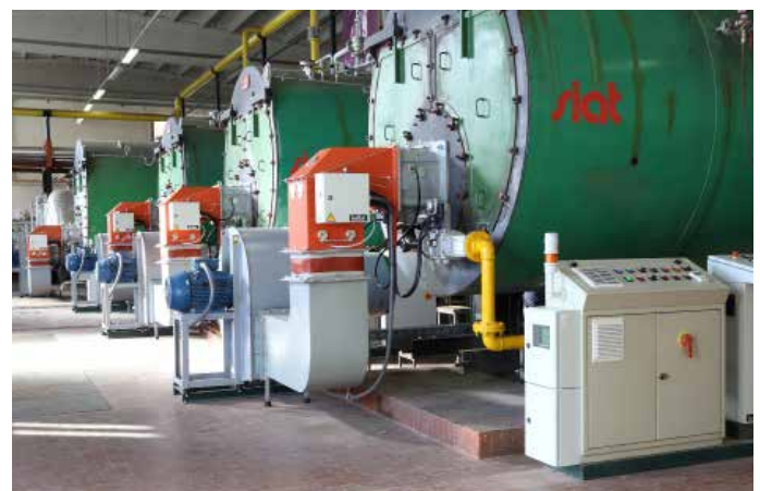
CALEFACCIÓN HOSPITALARIA Modelos de quemadores: Nº 2 IB 650 G ME CO V Nº 2 IB 1200 G ME CO V - modulación electrónica - inverter y control de CO NOx <100 mg/kWh
