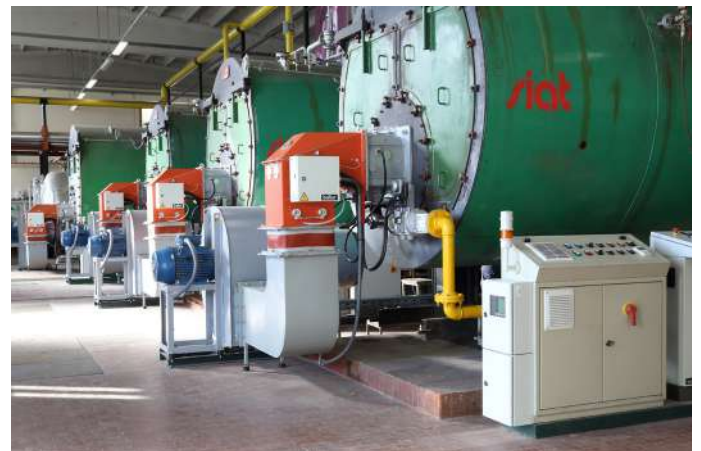
医院供暖 燃烧器型号: 2 台 IB 650 G ME CO V、 2 台 IB 1200 G ME CO V - 电子调制 - 逆变器和 CO 控制器 NO x <100mg/kWh
