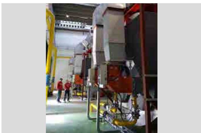
TELERICILDAMENTO Modelli bruciatori: N°6 IB 1200 G ME LX - modulazione elettronica - testa di combustione a bassi NO x - controllo O 2
