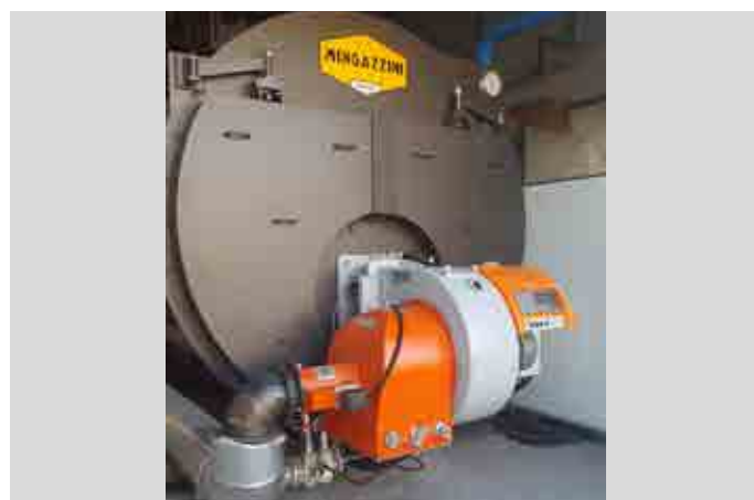
CARTIERA - SPECIAL PROJECT Modello bruciatore: TBG 1100 ME V O 2 FGR - controllo O 2 , inverter e sistema di ricircolo dei gas NO x <80mg/kWh
